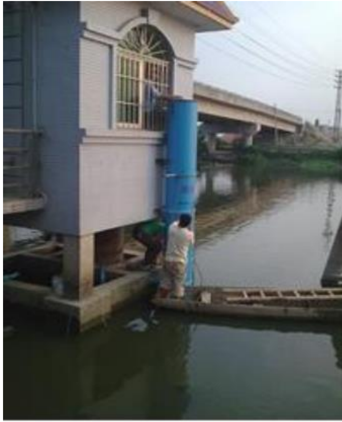
图3-11 仪器设备安装固定在测井中
