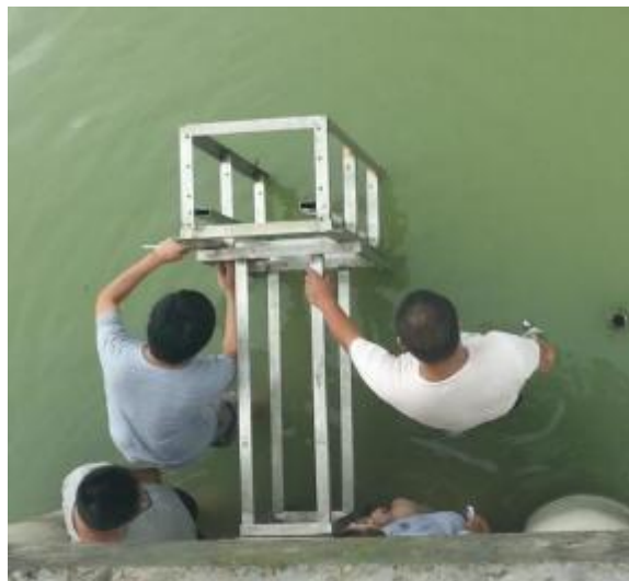
图 3-6 利用站房（桥墩）桩基固定
