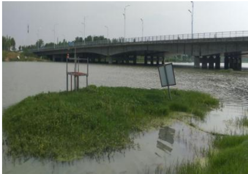
图 3-7 靠近河岸边打桩固定安装
