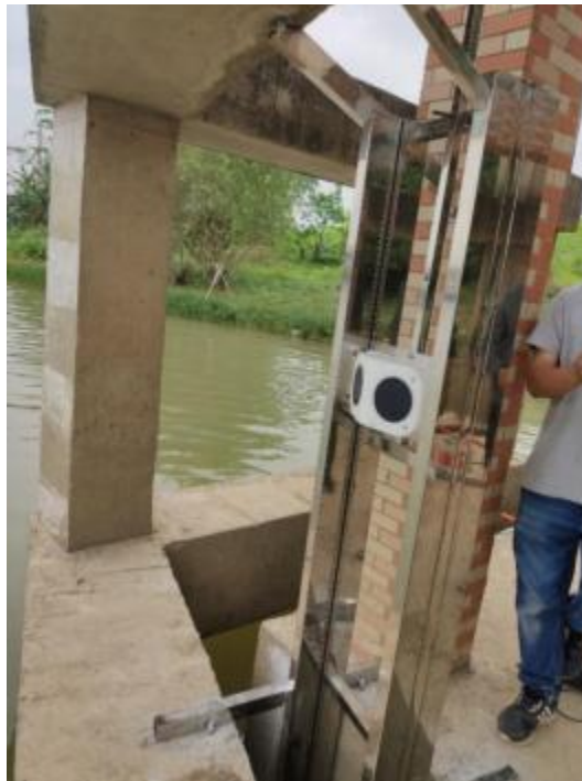
图 3-5 利用站房桩基固定滑轨支架
