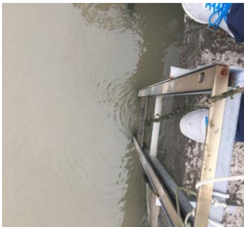
图 3-9 升降滑轨上的安装板上固定安装
