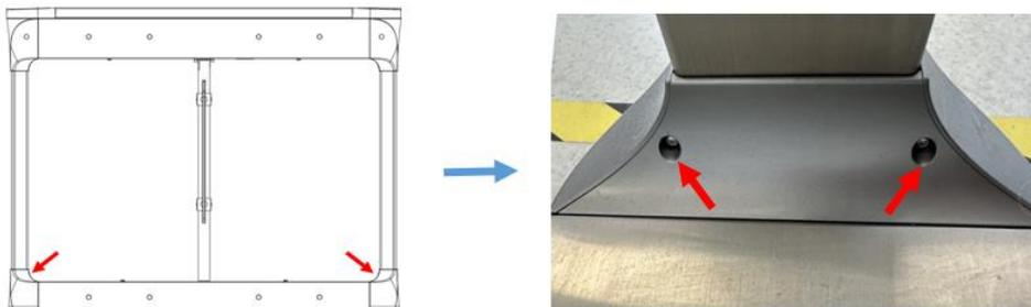
2. 将闸机搬至指定位置放好，在膨胀螺丝打孔处用马克笔标注打孔位置；
