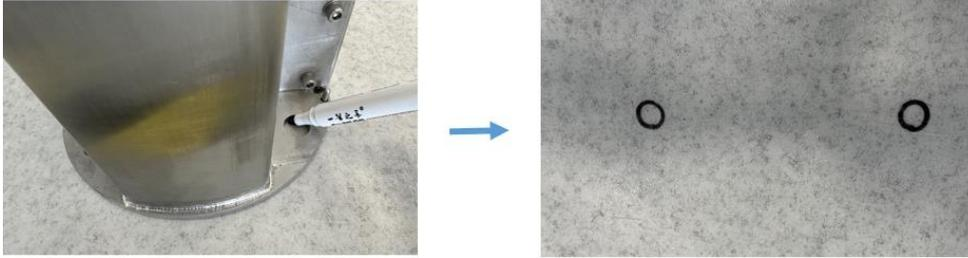
3. 将闸机搬走，在标记点进行打孔并打入膨胀螺丝。
