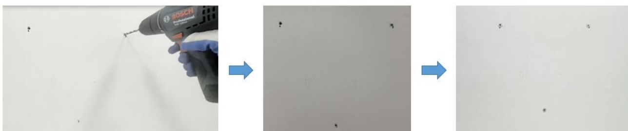
图2-2 打孔及打入膨胀螺栓
